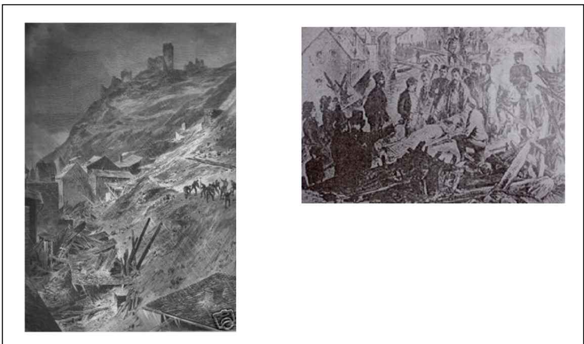
Abbildung 4: Rettungsarbeiten in Kaub 121
