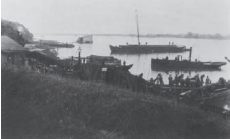
Die Verloaderampe in Krümmel am Ende des 19. Jahrhunderts
