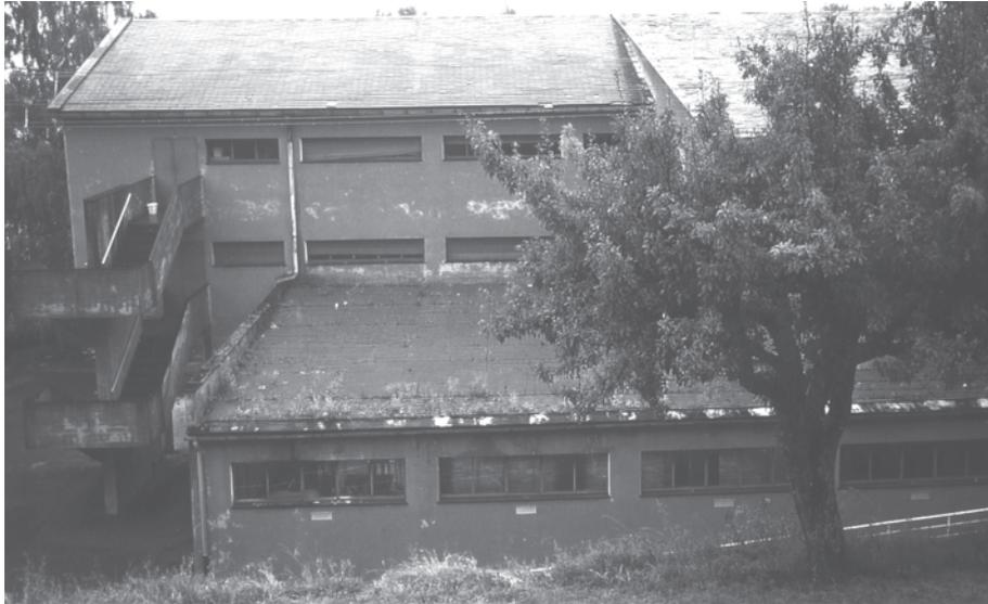
Abb.139 Ferienkolonie „Rinaldo Piaggio“ (Zustand 1996): Nordostecke des Hauptgebäudekomplexes; hochgelegene Fensterbänder bestimmen die Nordwand der Schlafsäle; im Vordergrund links eine der beiden nachträglich angebauten Feuertreppen
