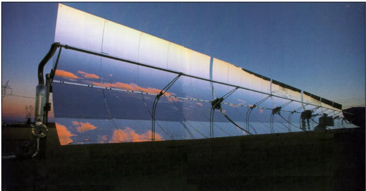
**Bild 1.1** SEGS-Parabolrinnenspiegel in Kalifornien (117)
