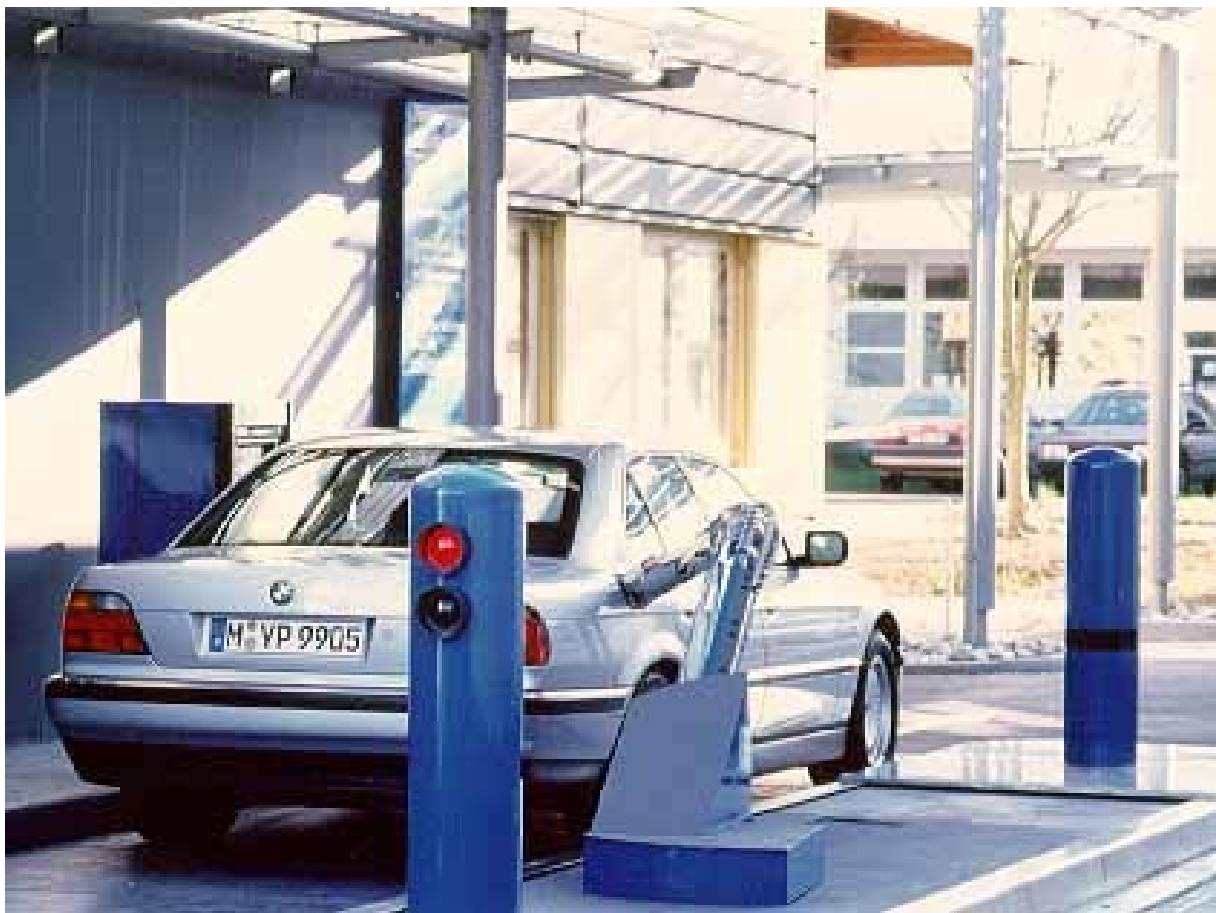
Bild A 5.4: Robottankanlage zur Befüllung des Fahrzeuges mit LNG bzw. LH 2 [WURSTER 97/2]
