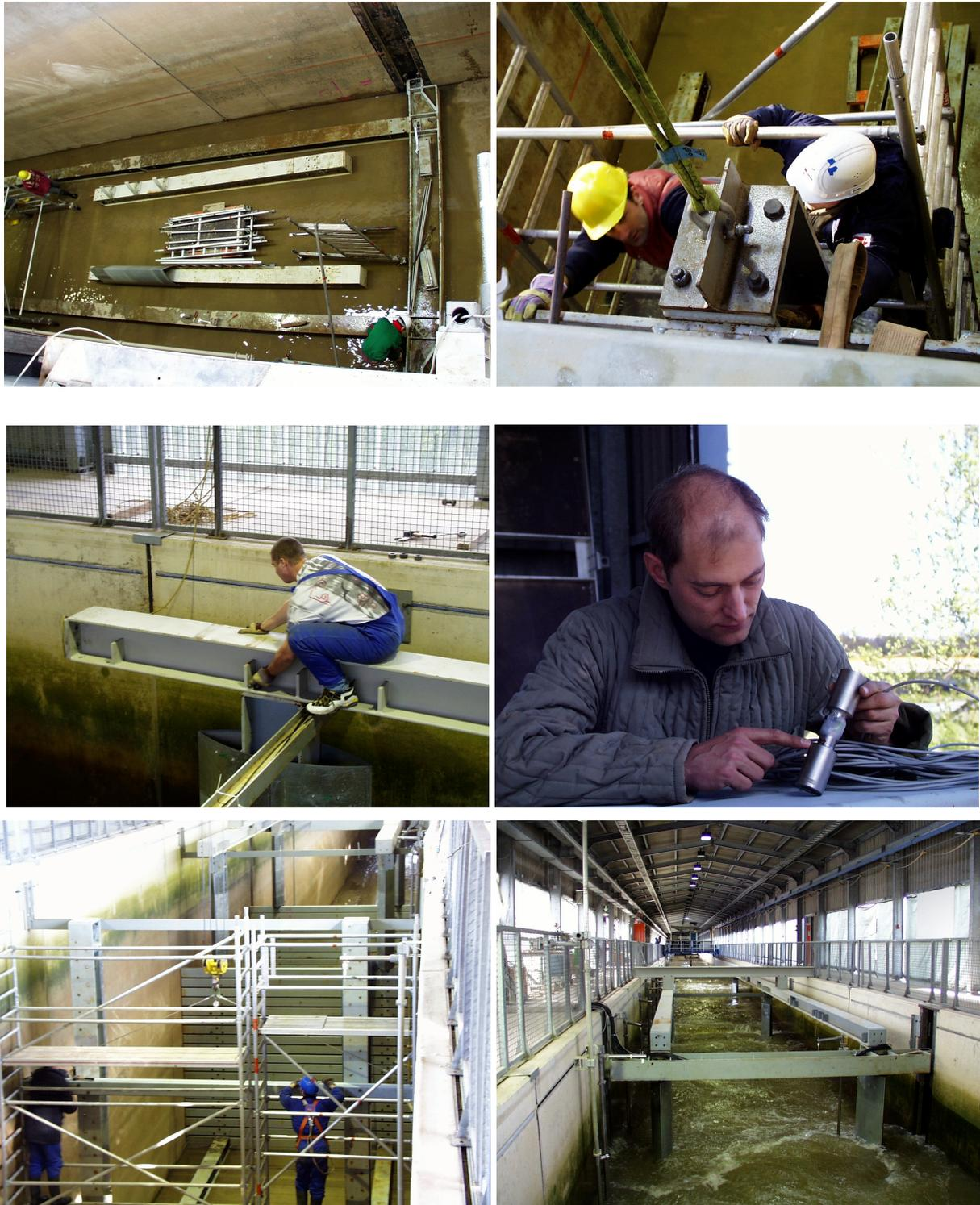
Abb. 11.1: Aufbau eines Zweikammersystems (GWK)
