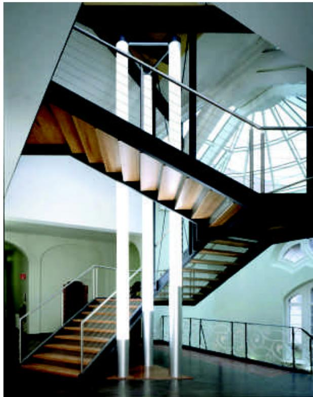
Bild 48: Hohllichtleiterinstallation in einem Foyer
