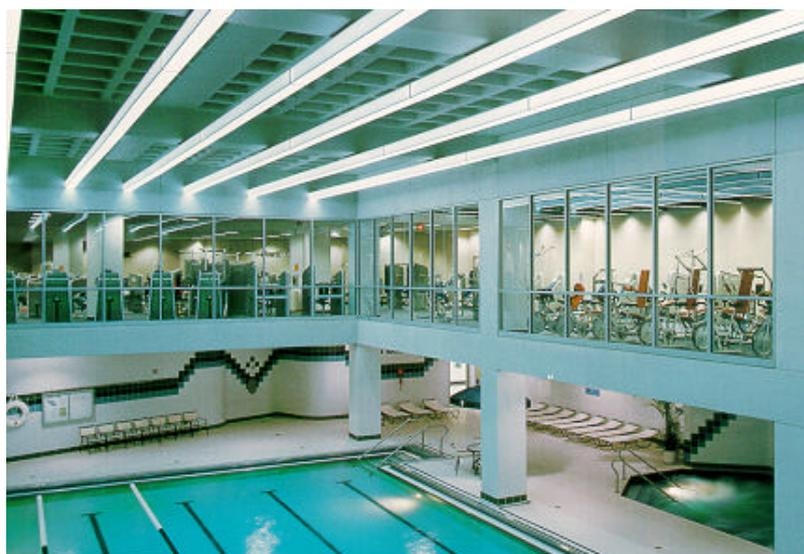
Bild 46: Hohllichtleiterinstallation in einem Schwimmbad /68/
