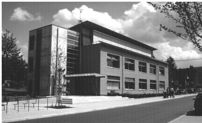
Abb. 4-25: Ansicht der Verwaltungsgebäudes des Ingenieur- und Vermessungsbüros Hans Lamparter GbR in Weilheim a. d. Teck [Foto: D. Hennings]
