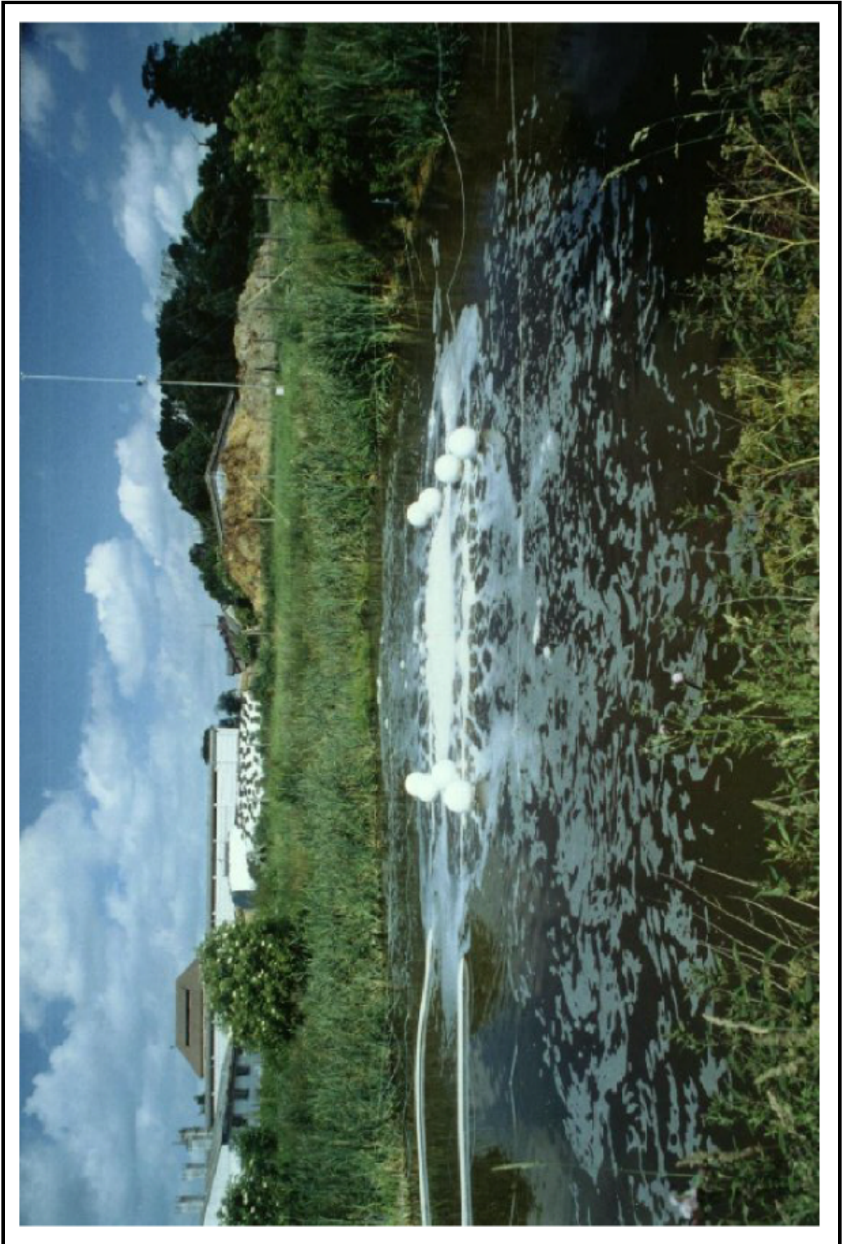
Bild 1. Technisch belüfteter Abwasserteich in Groß-Flotow (Landkreis Waren an der Müritz)
