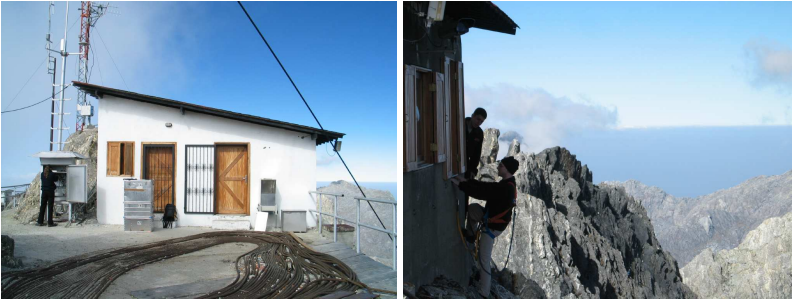
Abbildung 2.1: Linkes Bild: Das Gebäude der MARS Station auf dem Pico Espejo. Rechtes Bild: Außenarbeiten am Messfenster für das Wasserdampfradiometer, aufgrund der mehrere hundert Meter abfallenden Steilwand an der Nordseite sind Sicherungsmaßnahmen notwendig.
