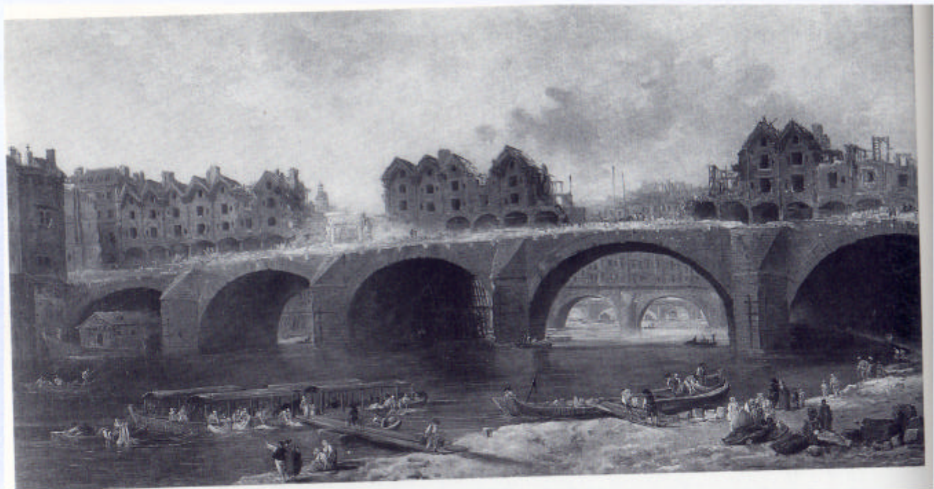
Abb. 38: „La démolition des maisons du Pont Notre-Dame“, Hubert Robert (Paris Musée du Louvre)
