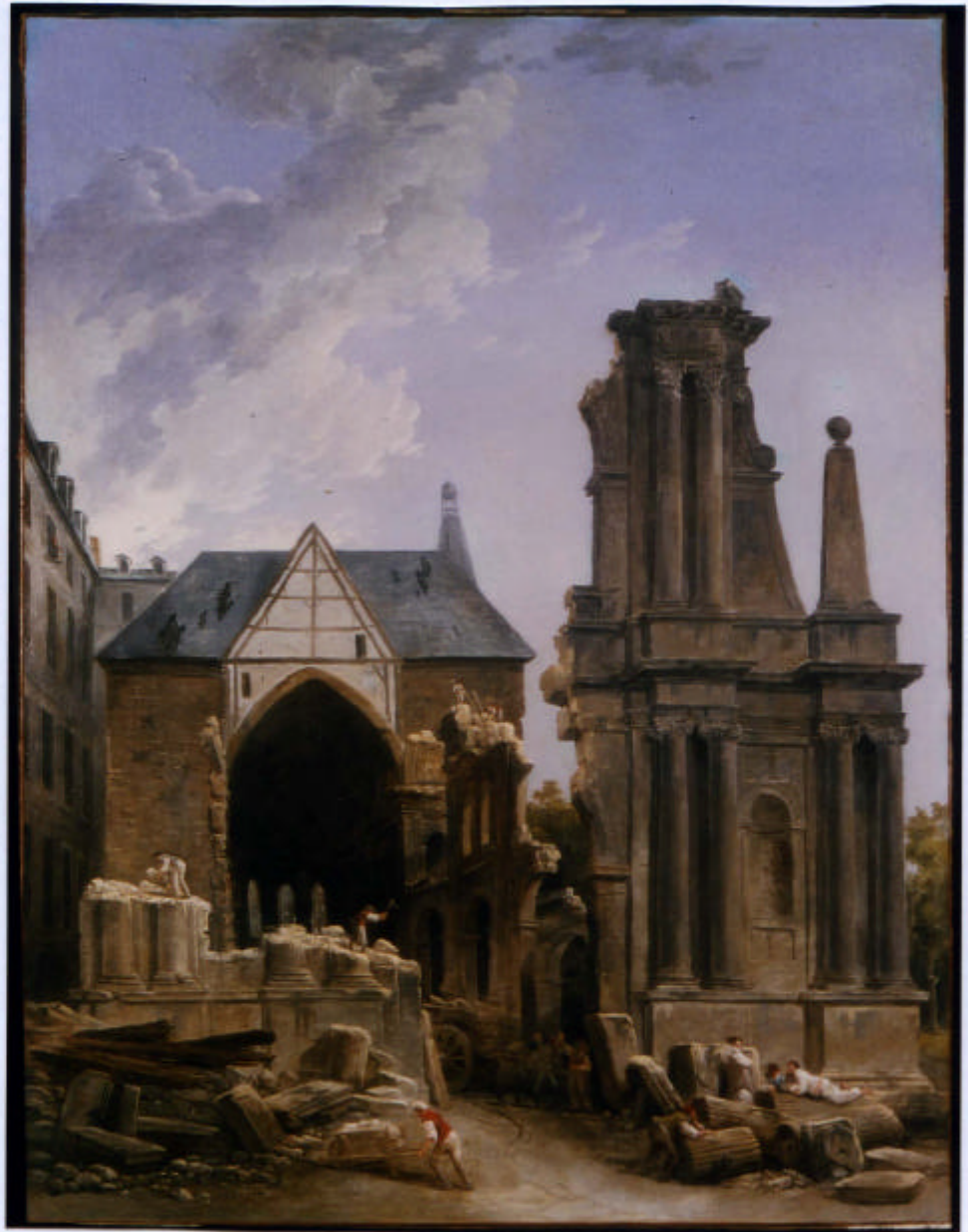
Abb. 58: „La démolition de l'église des Feuillants“, Hubert Robert (Paris Musée Carnavalet)
