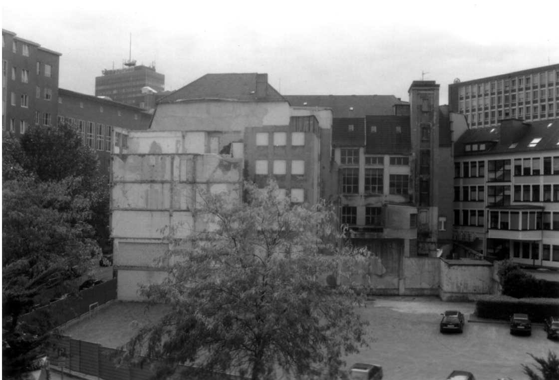
Abb. 63 Hinterhoffront des Gebäudes Bachstr. 3, Foto Verfasser 2002
