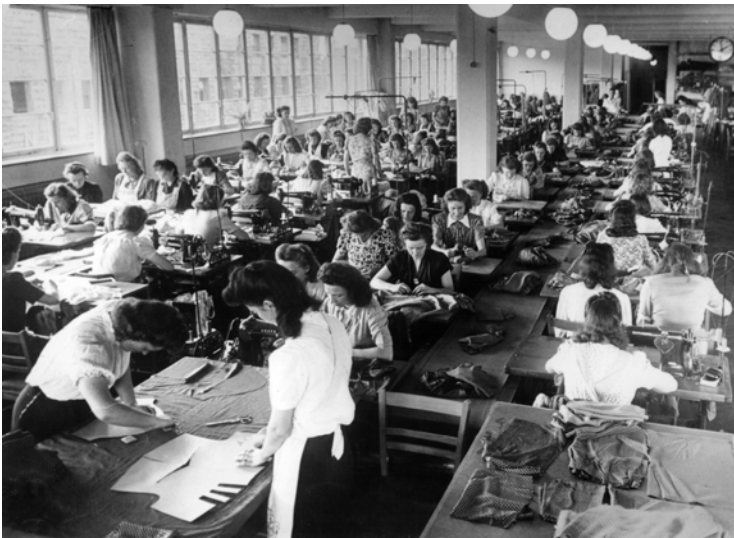
Abb. 75 Nähsaal in dem Gebäude der FABRA („Cunda“, C&A) (Stadtbildstelle Essen)
