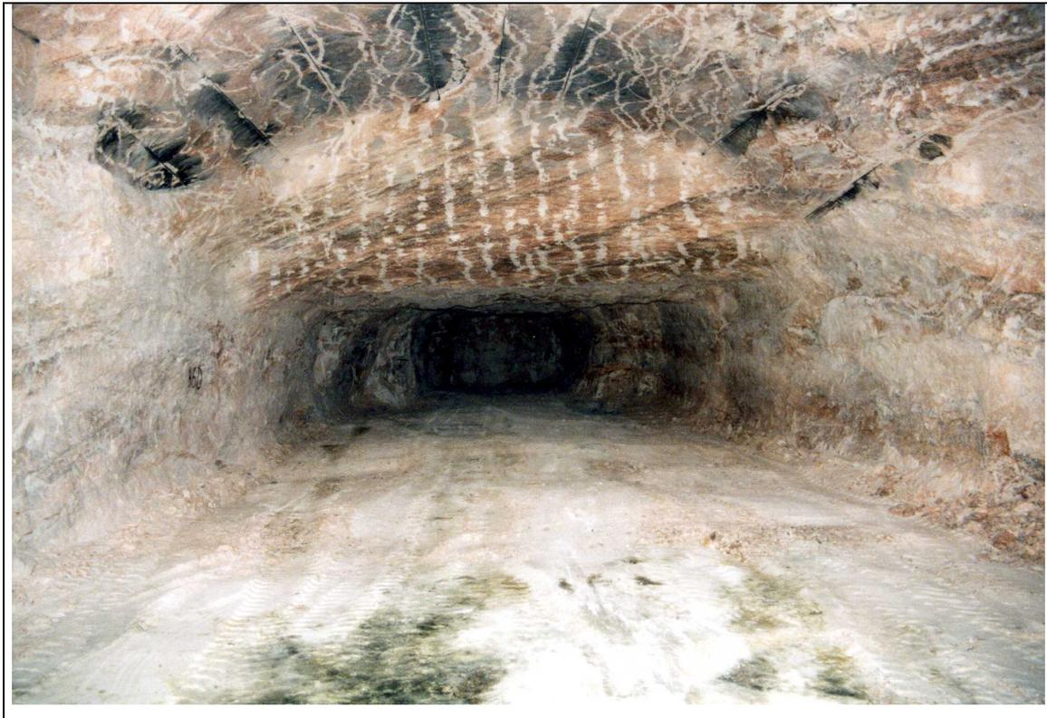
Bild 23: Herstellungsphasen im Querschnitt am Beispiel einer Vorrüstungsstrecke; Örtlichkeit: Zielitz, Westfeld, Teufe: ca. 600 m (Foto: L. Baumgarten, 2004)
