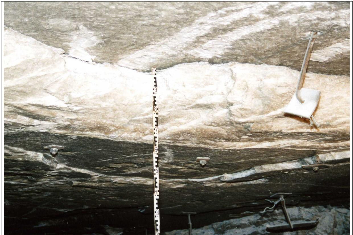
Bild 56: Wirkungsloswerden von Anker durch Ausbrechen benachbarter Schichtpakete; Ablösemächtigkeit: ca. 30 cm; stark deformierte Ankerstange als Ergebnis des Nachberaubens; Beraubespuren; Nachankerung; Örtlichkeit: Zielitz, ca. 900 m Teufe; Standzeit des Hohlraumes: ca. 25 Jahre (Foto: L. Baumgarten, 2004)
