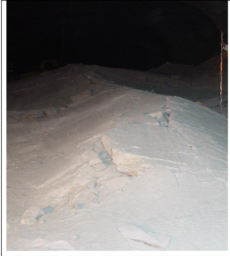
Bild 89: Sohlaufbruch bis 80 cm Höhe und Risse senkrecht zur Kammerlängsachse; Örtlichkeit: Zielitz, ca. 900 m Teufe; Standzeit des Hohlraumes: ca. 5 Jahre (Foto: A. Hausdorf, 2004)
