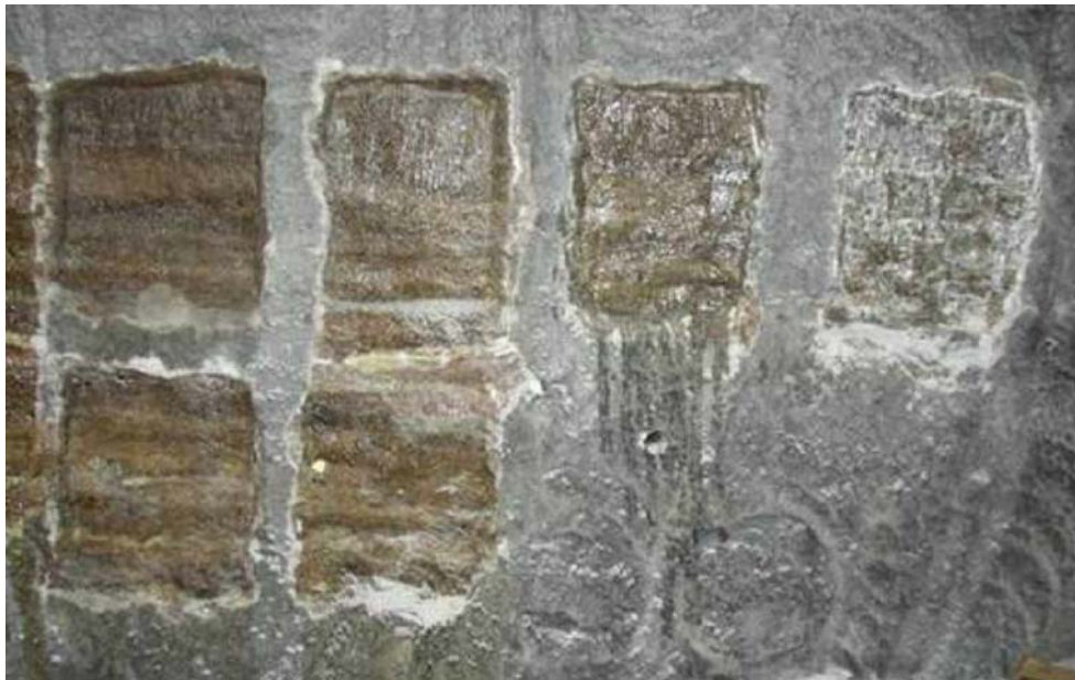
Abb.6: In-situ Prüfung der Beschichtungen
