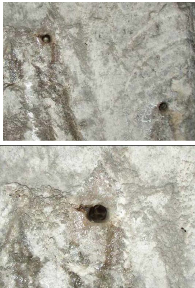
Abb.5: Bohrlöcher zum Einpressen des Injektionsmittel
