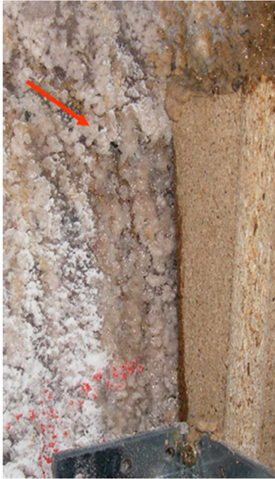
Abb.54 a: Austritt des Injektionsmittels durch ein Riss bei der Injektion
