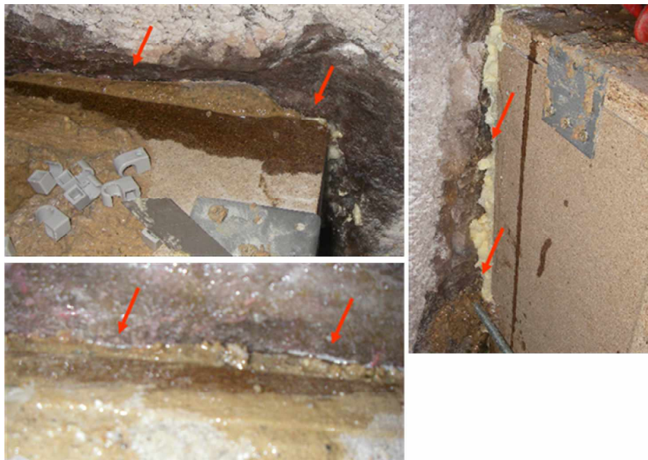
Abb.47: Seitenausstritte des Injektionsmittels bei der Durchführung der Injektion
