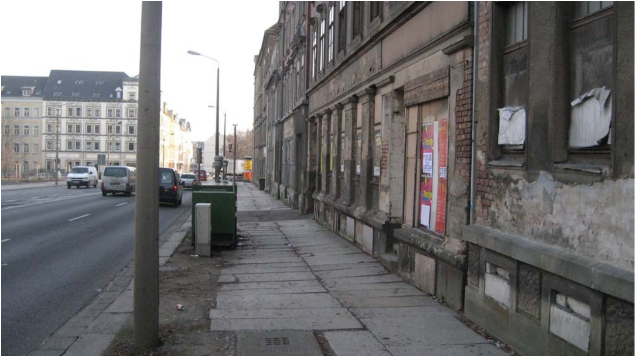
Abbildung 3: Fehlende Aufenthaltsqualität an der Leipziger Straße (Blickrichtung Süden) vor den fraglichen Häusern. An der östlichen Straßenseite ist das ehemals geschlossene gründerzeitliche Karree bereits aufgebrochen worden; dadurch ist die Straße in diesem Abschnitt an einer Seite anbaufrei. Quelle: Eigenes Foto, Januar 2008
