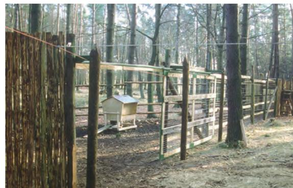
Abb. 2: Schiebefangtor in einem C-Eisenprofil auf Wälzlager geföhrt, am Damwildfang im Forschungsgatter Rädikow
