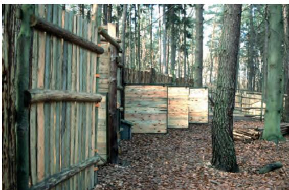
**Abb. 3: Separationssektion mit drei Abteilen und geöffneten Schiebetoren**
