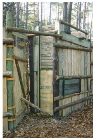
**Abb. 5: Außenansicht eines Manipulationsabteils mit drei verschiebbaren Seiteneingriffen und leicht und schnell zu bedienender Falltür zur sicheren und streßarmen Arbeit am Wild**
