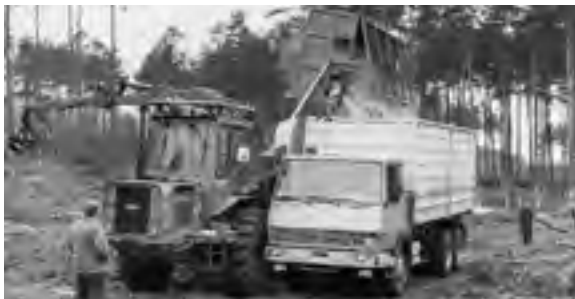
Abb. 514: Hackschnitzelübergabe an Spezialkipper Steyr 91 (HUBE)
