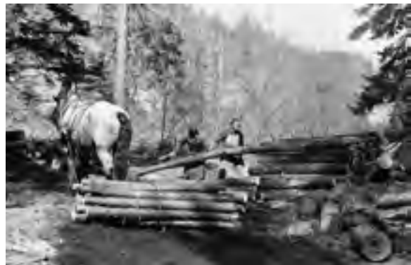
Abb. 397: Schichtholzschleifen mit Pferd (THIEL)
