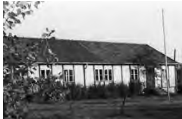
Abb. 6: Gebäude der Abt. Forsttechnologie in der Schleusenstraße Eberswalde (Archiv IFE)
