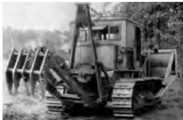
Abb. 163: Luckenwalder Haken am Kettentraktor S 100 (Archiv BÜTTNER)
