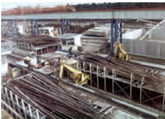
Abb. 548: Drei Einschnittlinien unter der 10 t-Brückenkrananlage (LÜDDEMANN)
