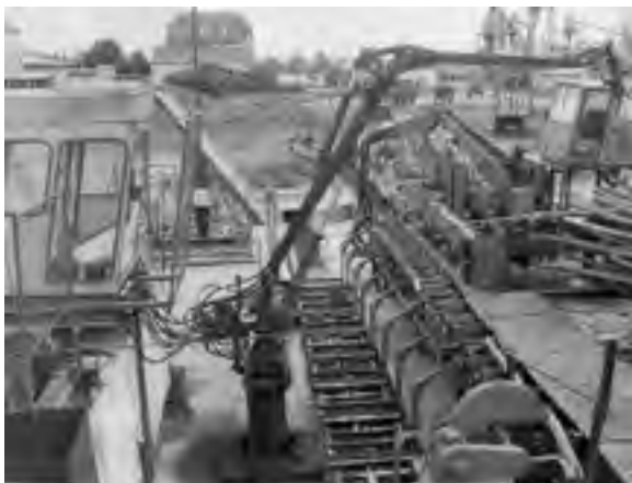
Abb. 553: Dünnholz-Stapelschnitanlage Roßlau (Archiv ZfP)
