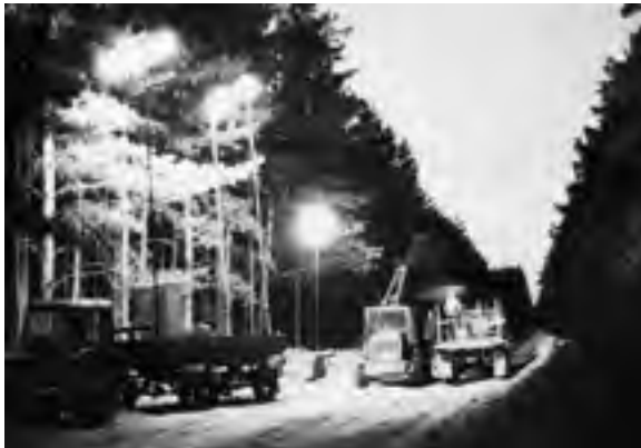
Abb. 295: Mobile Beleuchtungsanlage Neustrelitz (Archiv ZfP)
