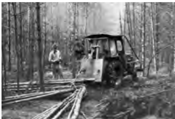
Abb. 378: Zusammenziehen von Stangenbündeln mit Rückeausrüstung RA 20-002 (Archiv TuT)
