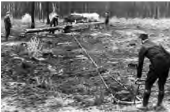
Abb. 160: Göpelrodung mit „Waldteufel“ (Archiv RÖMPLER)
