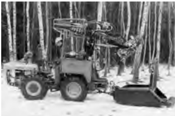
Abb. 381: Funktionsmuster der Selektionsfällsammelmaschine DFR 20 (Archiv KFTW)
