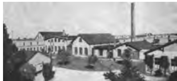
Abb. 30: Teilansicht der Fabrikanlage „Wigöwi“ (Werkfoto)
