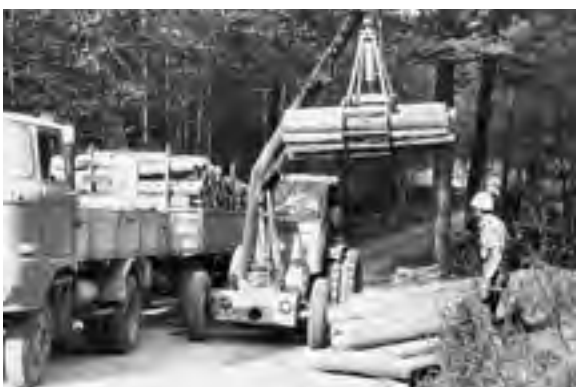
Abb. 488: Mobillader T 157-2 beim Laden von Schichtholz (Archiv RÖMPLER)
