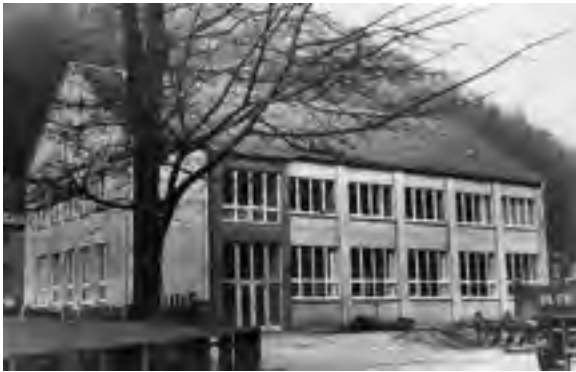
Abb. 8: Das 1960 bezogene neue Institutsgebäude an der Dresdener Straße (Archiv IFI)
