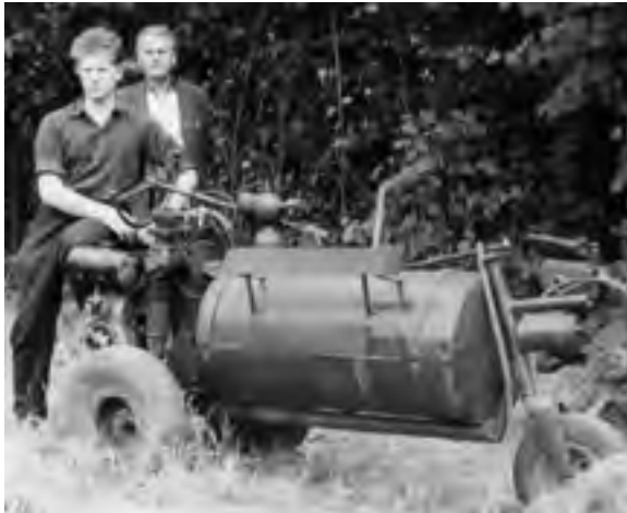
Abb. 246 : Forstschutz-Spritzgerät Neuruppin (Archiv BÜTTNER)
