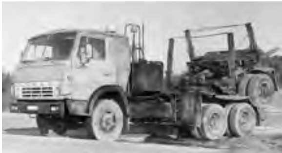
Abb. 511: Kamas-Langholz-LKW mit FA.6 und aufgesatteltem Nachläufer HN. 80.58 (Archiv Oberlichtenau)
