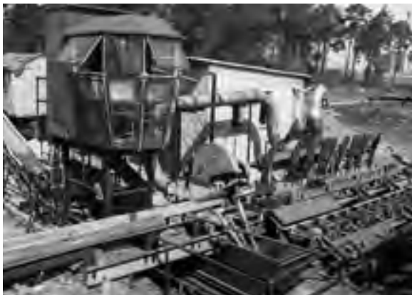
Abb. 51: Die Holzausformungsanlage in Britz des StFB Eberswalde (Archiv ZfP)
