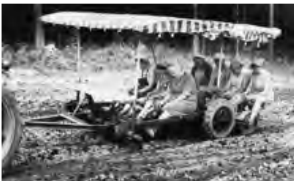
Abb. 98: Maschinelle Verschulung mit der Pfl 7 F (Archiv BÜTTNER)
