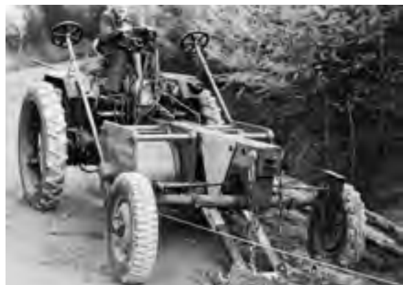
Abb. 453: Geräteträger RS 09 mit Doppeltrommelseilwinde RW 606 (Archiv TuT)
