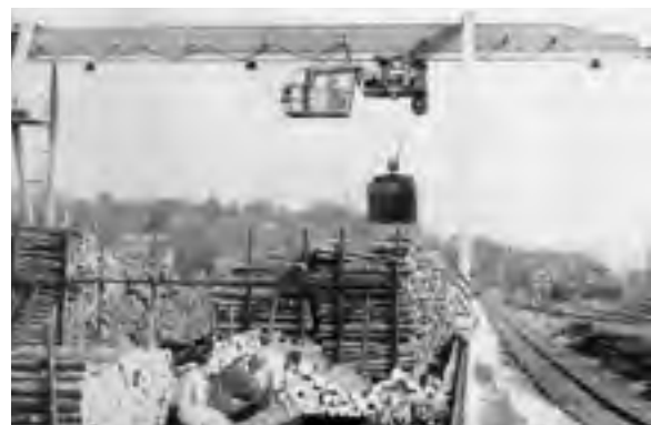
Abb. 538: Gelenkkreissäge, Schichtholzlager und Portalkran auf dem HAP Schleusingen des StFB Suhl (SCHULZ)
