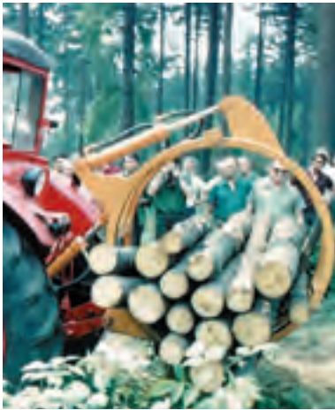
Abb. 431: Schichtholz-rückgreifer Salzwedel (Archiv TuT)
