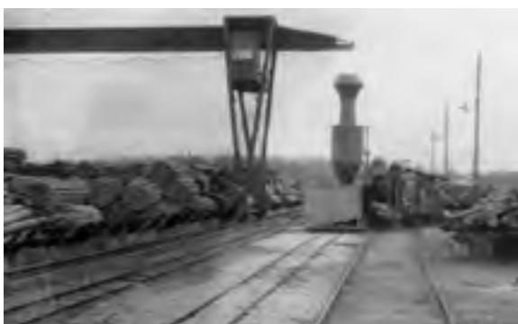
Abb. 537: Feldbahngleisanlagen mit Portalkran, Rindenabsauganlage und Rindencontainer (SCHULZ)
