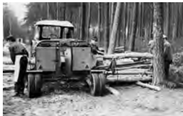
Abb. 315: Faserholz-Entrindung mit der finnischen Entrindungsmaschine VK 16 (HAUSMANN)
