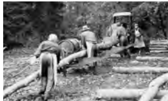
Abb. 291: Fahrbare Einschnittanlage Perleberg (Archiv RÖMPLER)
