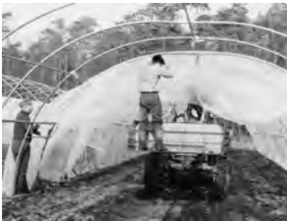
Abb. 129: Manuelles Aufziehen der Folie (Archiv WSD)
