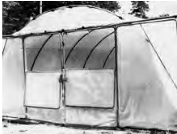
Abb. 137: Giebelbelüftungsklappen (Archiv WSD)
