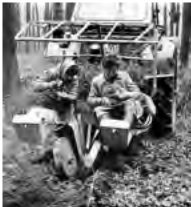
Abb. 213: Pflanzmaschine WT-2, 1982 (Archiv ZfP)
