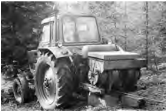
Abb. 451: Seilrückeanlage Königstein, Doppeltrommelseilwinde SKR 2 am MTS-52 (HASCHKE)
