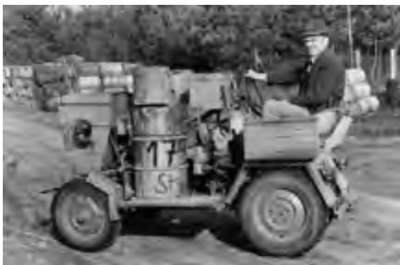
Abb. 559: Harzschöpfmaschine des StFB Luckenwalde (Archiv BÜTTNER)
