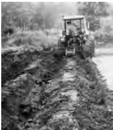
Abb. 172: Aufpflügen von Dämmen mit D4K-B (HUBE)
