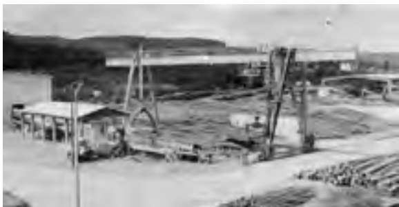
Abb. 551: Entastungsanlage EA-10 G mit Polter und Vereinzeler (Archiv RÖMPLER)
