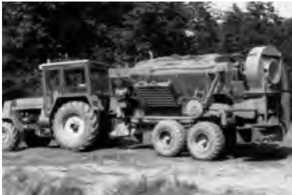
Abb. 219: Kalkblasgerät WBG-1 (Archiv ZfP)
