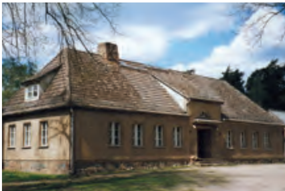
Abb. 10: Verwaltungsgebäude in Menz-Neuroofen (DAVIS)
