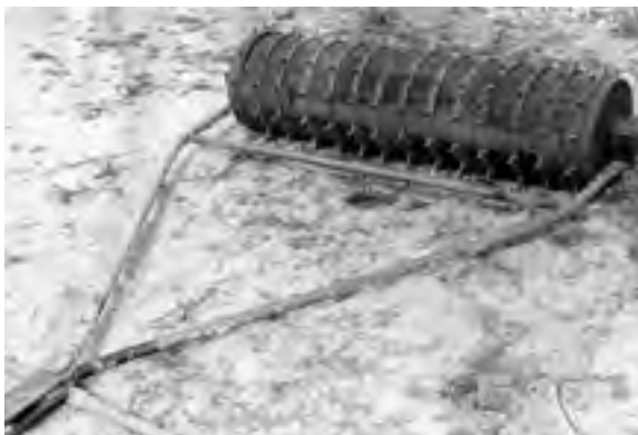
Abb. 140: Walze zum Markieren der Steckplätze (Archiv WSD)
