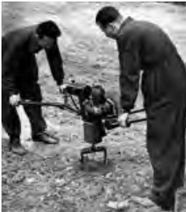
Abb. 179: Pflanzplatzbohrer „Wühlmaus“ (Archiv RÖMPLER)
