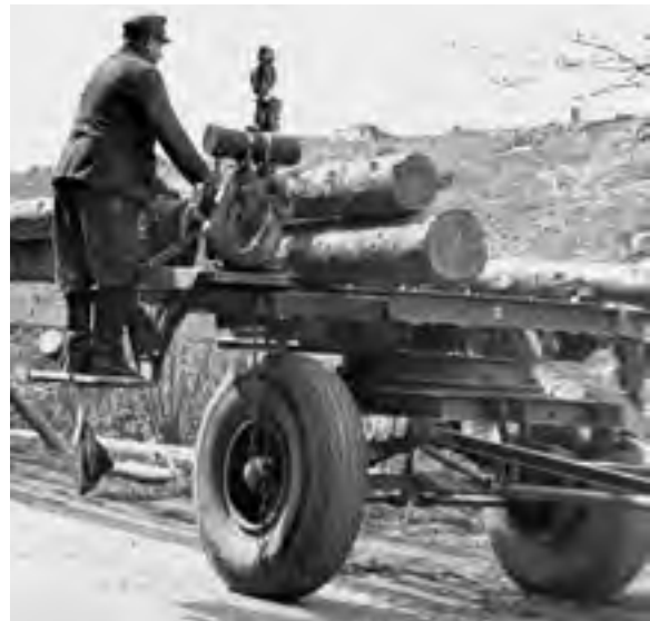
Abb. 470: Beladen eines 8 t-Langholzanhängers mittels Beladewinde (Archiv RÖMPLER)
