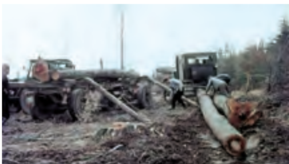
Abb. 409: Rücken mit Kettentraktor S 100 und Anhängerbeladung durch Traktorenzug (WETZEL)
