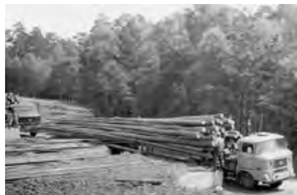
Abb. 484: Stammholzentladung mit stationärer Winde (Archiv RÖMPLER)
