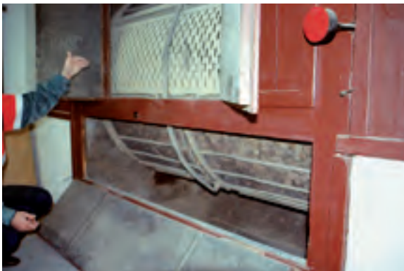
Abb. 72: Trommeldarre in Jatznick (HAFEMANN)
