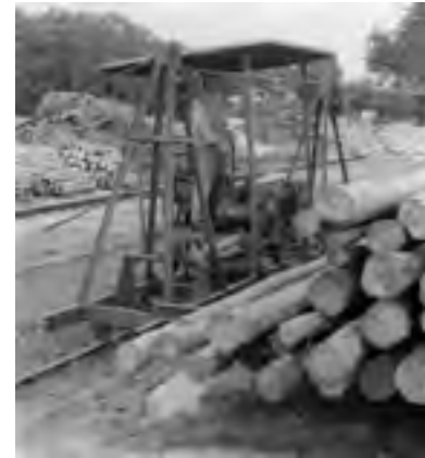
Abb. 535: Ent­ladeseilwinde auf dem HAP Genthin (SCHULZ)
