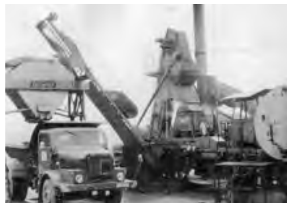
Abb. 526: Asphaltmischanlage Leupoldishain des StFB Königstein (HAUSMANN)
