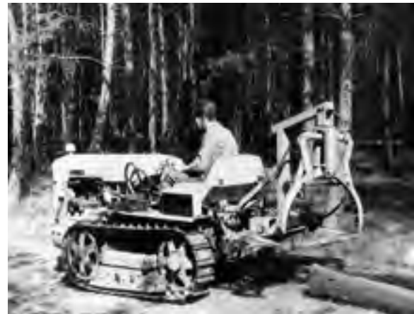
Abb. 410: Kettentraktor Bolgar TL 45 mit Rückezange (SCHULZ)
