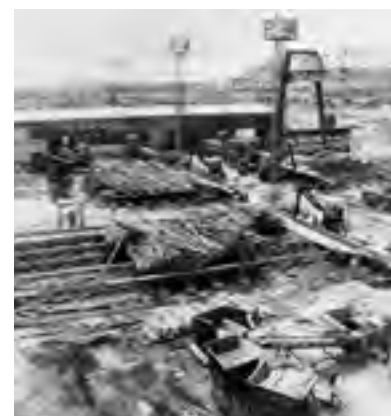
Abb. 545: Gesamtansicht der Ausformungsanlage Tangermünde (Archiv FIEDLER)
