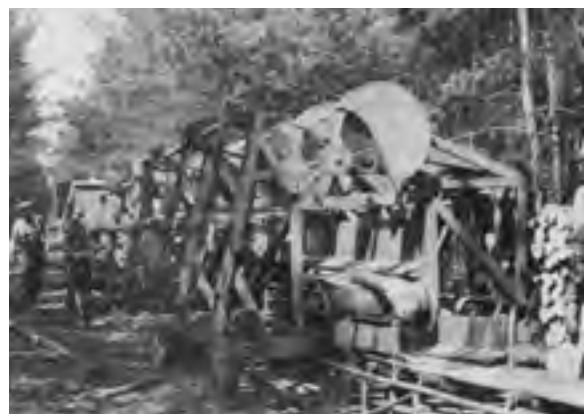
Abb. 286: Fahrbare Mehrblattkreissäge Kyrizt (BEYER)
