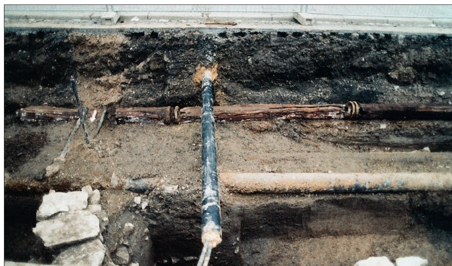
Bei Bauarbeiten in der Wendenstraße gefundene alte Holzwasserröhren. (Foto: Stadtarchäologie, mit freundlicher Genehmigung von Betty Arndt)
