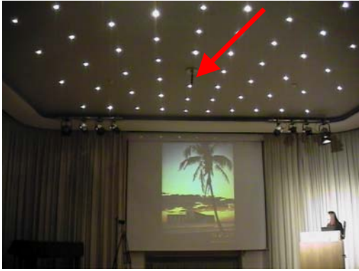
Abbildung 7: KEM an der Decke
