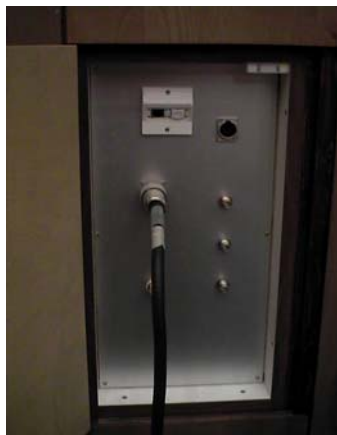
Abbildung 2: Patch-Paneele an der Wand
