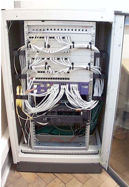
Abb. 6: 19"-Schrank mit dem Summit 48 (mitte) und dem Omniswitch 3 (unten)
